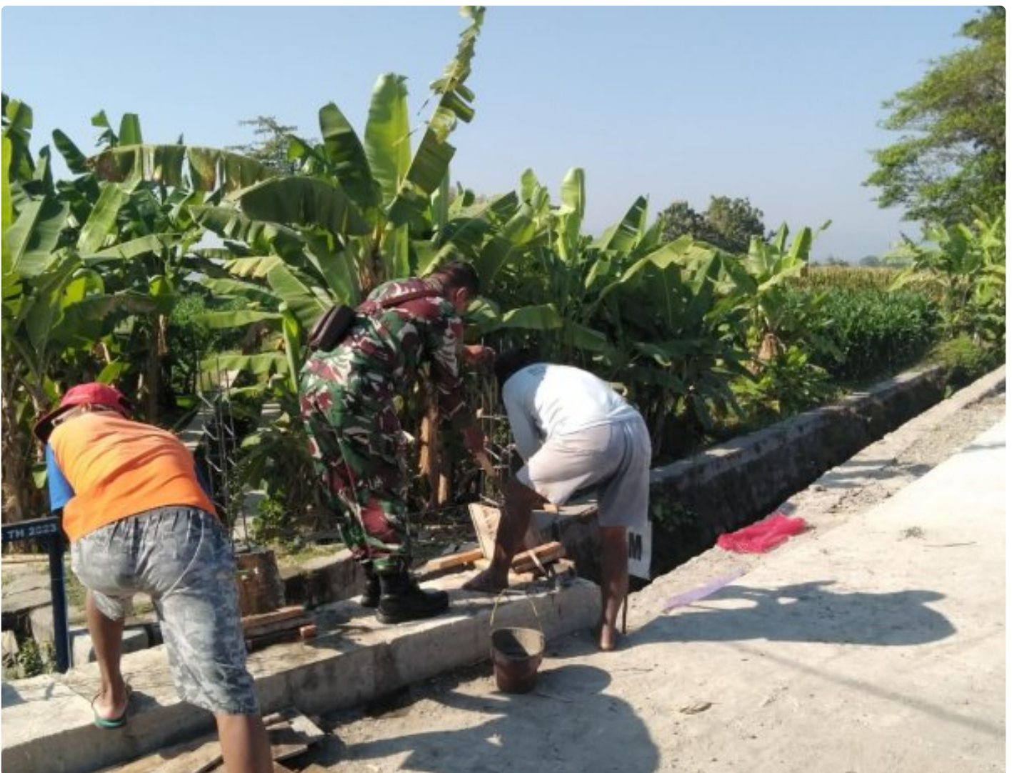
Tahap Finising Jembatan TMMD Reg 121 Kodim Klaten
